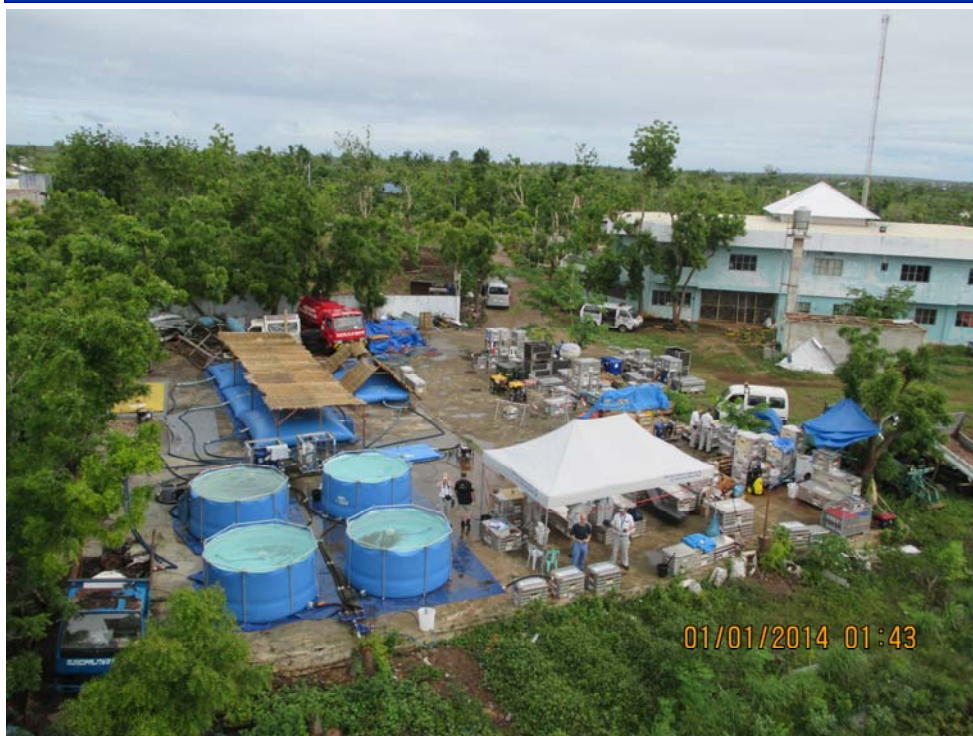
Links die Trinkwasseraufbereitungsanlage mit vier Rohwasserbehältern, Hintergrund rechts das Gebäude der Gemeindeverwaltung (Municipality) von Santa Fe
