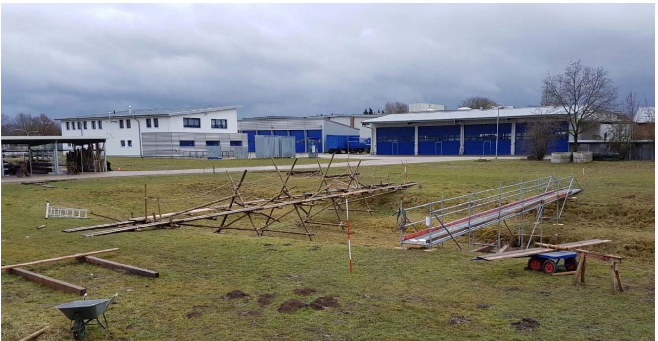
Links ein sogenannter China-Steg, rechts daneben ein Steg aus dem Einsatzgerüstsystem (EGS)
