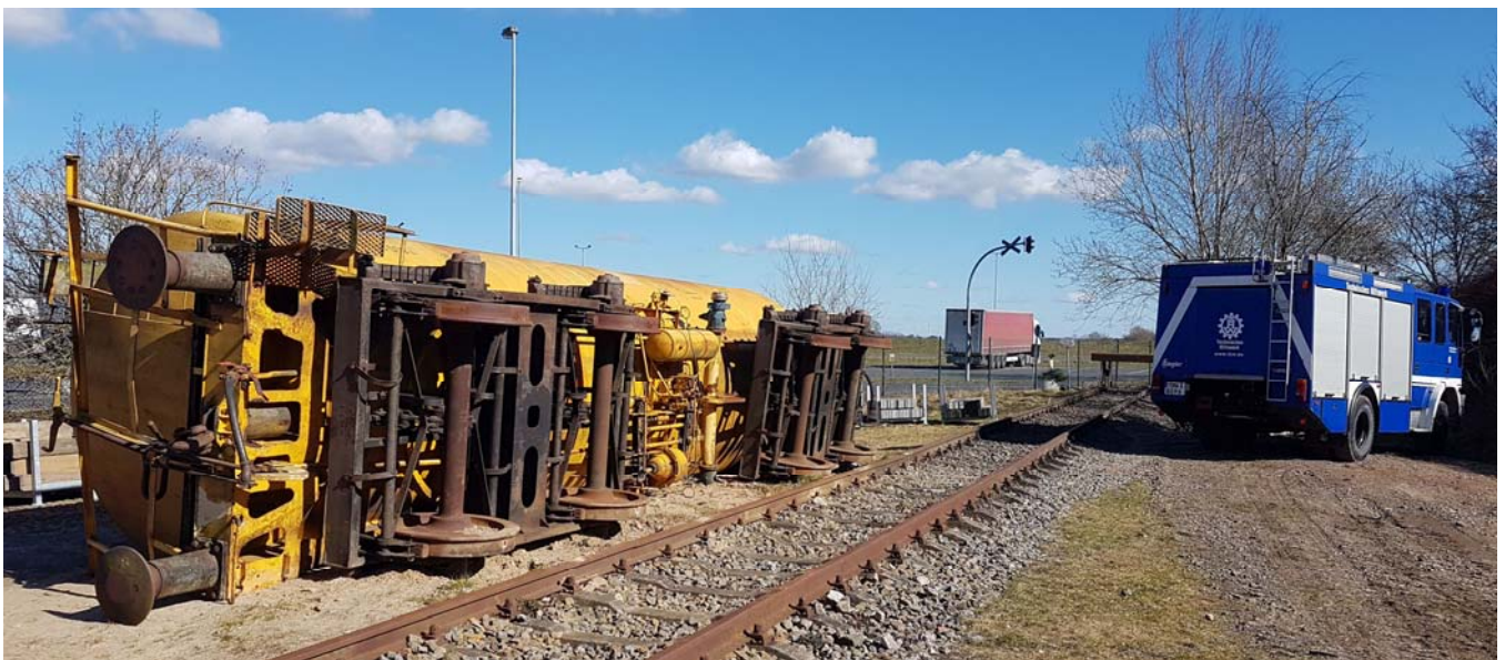
Station 3: Aufrichten und anschließendes Aufgleisen eines umgestürzten Kesselwagens mit zwei Drehstellen
