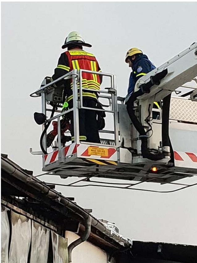
FB Bau bei der Erkundung des Dachs mittels TLK
