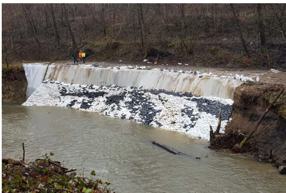
Das Gewässer „Wurm“ und der mit rund 38.000 Sandsäcken gesicherte Hang
