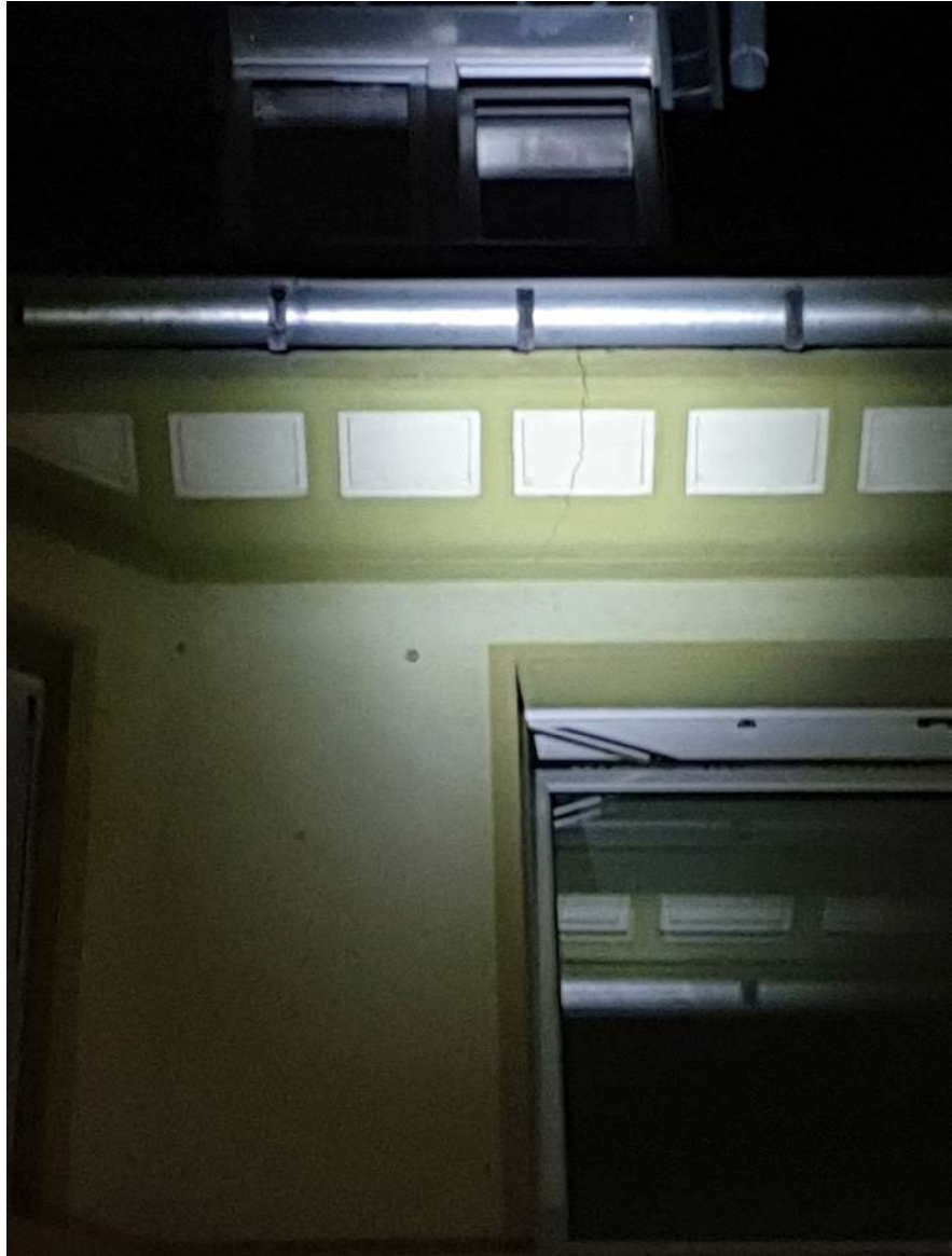
Oben: Riss im zweiten Obergeschoß von der Straße aus sichtbar
