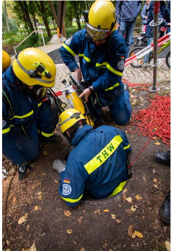
Oben: Der Einstieg in den 200m langen Kanal
