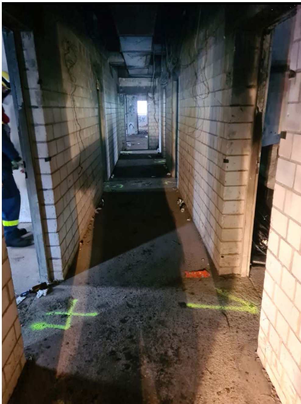
Oben: Blick in die Location, die Kennzeichnung der Räume - Nummer 1 bis 6 - auf dem Fußboden erfolgte während der Erkundung durch den Zugtrupp des THW Euskirchen. Sie dient zur Orientierung der Einsatzkräfte und der Zuordnung des sichergestellten Materials zu den einzelnen Räumlichkeiten.
